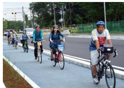
東京大学柏キャンパスの西側道路に設置された自転車専用レーン。車両や歩行者から分離され快適に走行できる。
