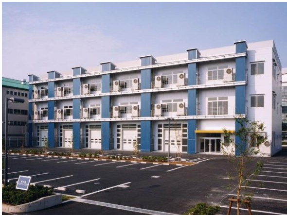
<東大柏ベンチャープラザ 外観>
