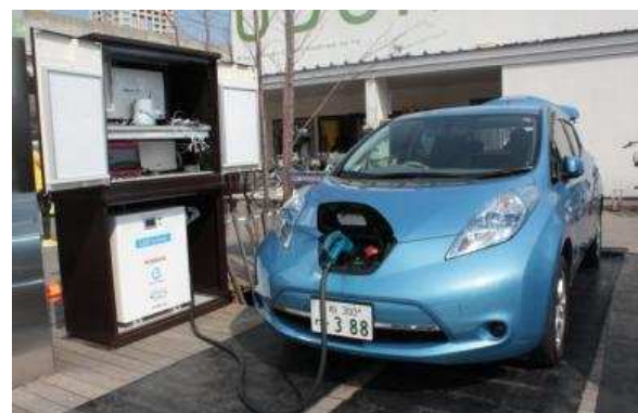
防災エネルギーボックスに接続するリーフ
